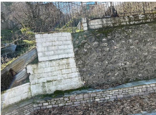
(Τοιχοποιία προς επισκευή με πέτρα)
