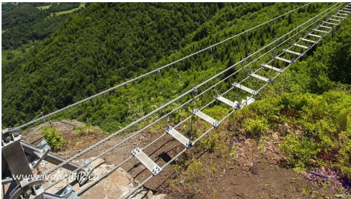
Εικόνα 8: γέφυρα τεσσάρων συρματόσχοινων θιβετιανού τύπου
